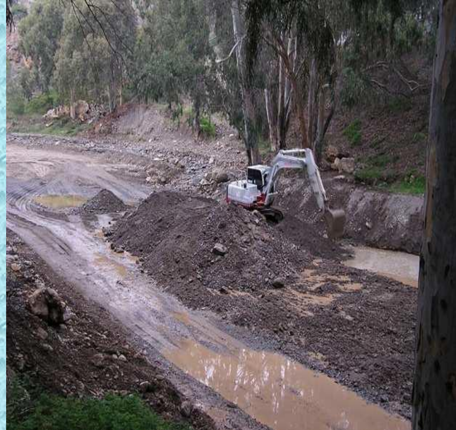
Habituales trabajos de “limpieza” de un cauce con maquinaria pesada (foto de Óscar Gavira)
